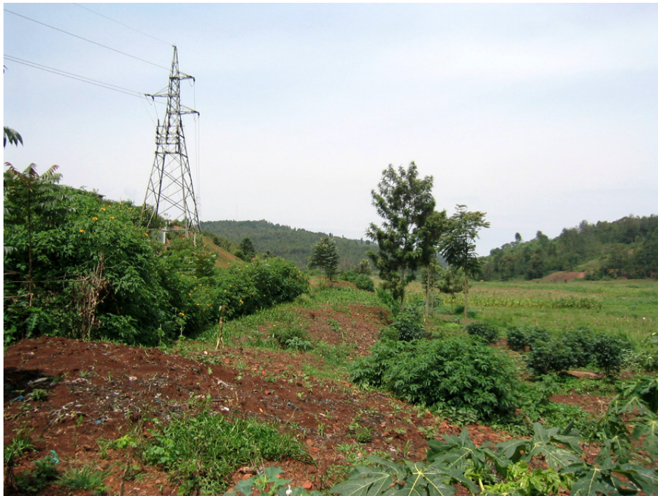
Ligne 30 kV – Butare
